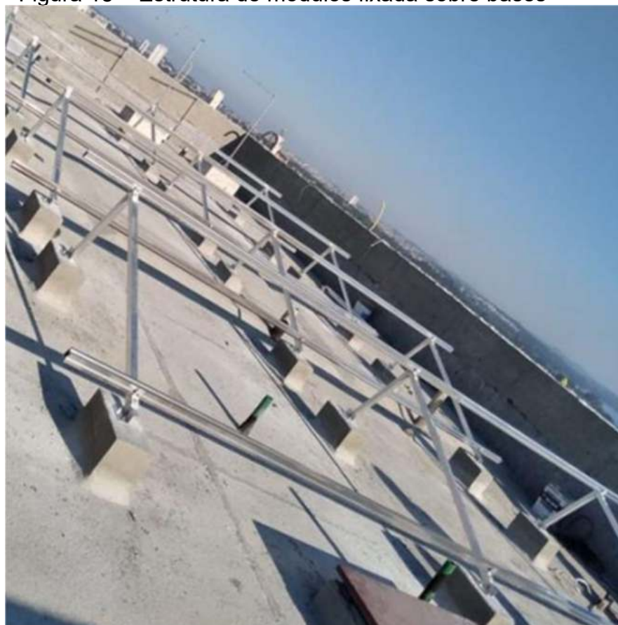
Figura 18 – Estrutura de módulos fixada sobre bases
