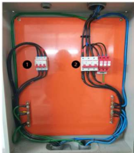
Figura 25– Detalhe dispositivos de segurança de entrada e saída
