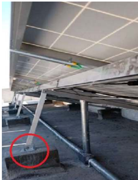
Figura 19 – Detalhe fixação de bases
